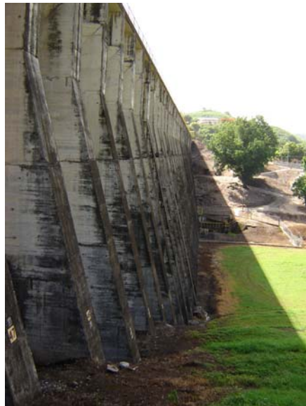
Foto 2: Sección de contrafuertes de la represa Guayabal
