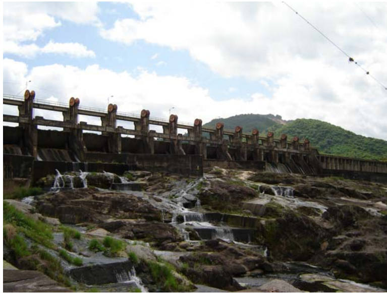
Foto 1: Sección de compuertas de la represa Guayabal
